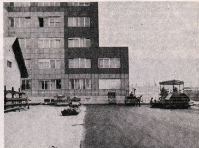
Na Lavi 7, zahodno od Poslovne stavbe Ingrad, imata sedež in proizvodne prostore dve naši temeljni organizaciji. Meje med njima praktično ni, saj so deponijski prostori TOZD Proizvodni obrati in parkirni prostori TOZD Mehanizacije na enem, celovitem prostoru. Pa vendar sta ti temeljni organizaciji, vsaka zase, naročili asfaltiranje svojega dela dvorišča, ena lani, ena letos. Foto B. Batalaki
