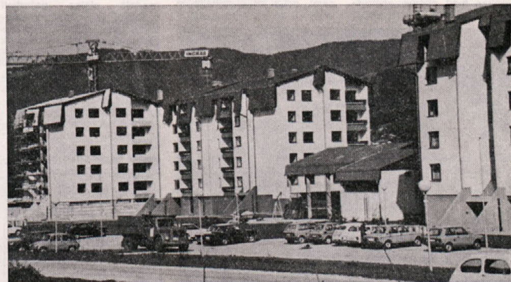
V soseski Debro pri Laškem gradnja novih 85 stanovanj
