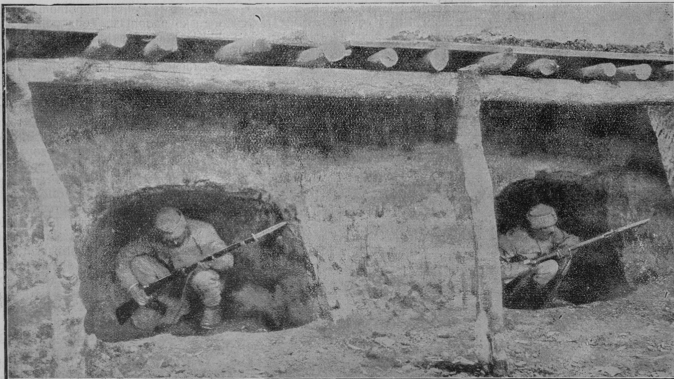
Podzemski strelski jarki na Poljskem, ki so zavarovani proti bombam in granatam.
