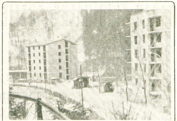
»Gorenje« iz Radevljice in »Gradbeno podjetje Tržič« sta zgradili ti dve stolpnici, v katerih bo 36 stanovanj. Med stolpnicama pa že kopljejo temelje za novo 20 stanovanjsko hišo
