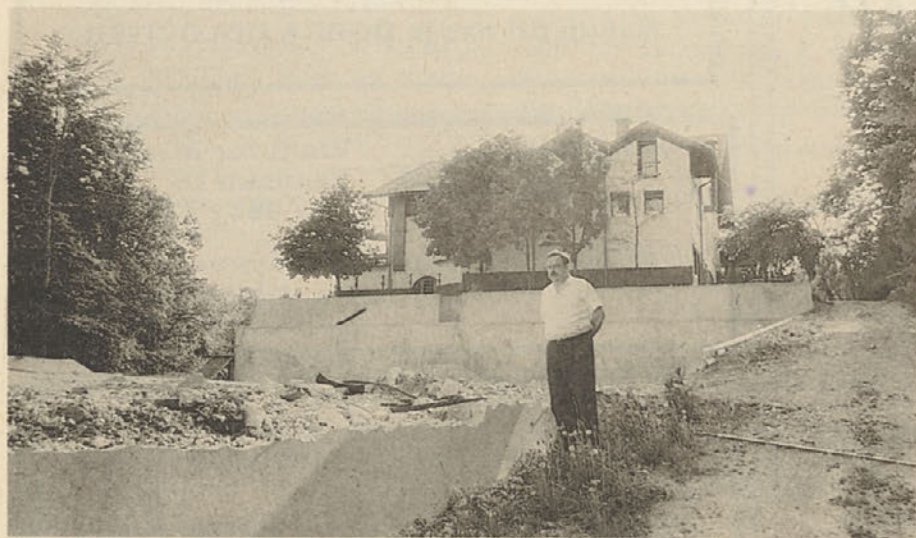
Maček pred porušenim zidom.
