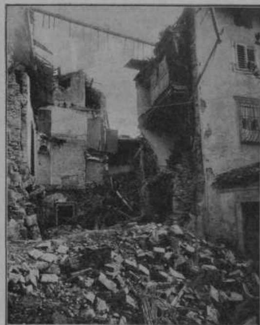
Porušena palača grofa Strassoldo l. 1915. v Gorici. Maja 1915., torej pred 16 leti, je Italija napovedala bivši Avstriji vojno. Med vojno je bila naša slovenska Gorica skoro popolnoma porušena. — Naši možje, ki so prestali vse grozote goriške fronte, na Doberdobo in drugod in so pozneje podili Italijane proti Pijavi, se neradi spominjajo groznih časov in kadar pripovedujejo o tistih dneh, so žalostni, ker je bilo njih trpljenje zastoj in slovenska Goriška kljub vsemu ni osvobodjena.
