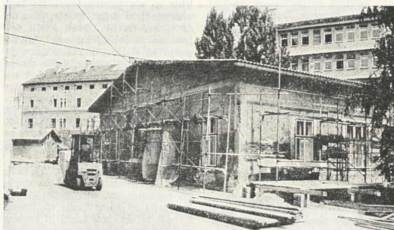
Prenovljeno obratno ambulantno in elektro delavnico je močno kazil zunanji izgled. Ureditev fasade in pleskanje oken sta v kratkem času močno spremenila dotrajano podobo
