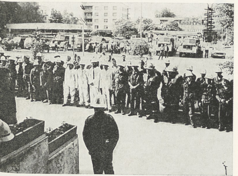
Po končani vaji je bil zbor vseh sodelujočih gasilskih enot pred upravno stavbo Papirnice Vevče. Vaja, ki si jo je ogledalo veliko krajanov, je potekala brezhibno in je bila silno zanimiva. Gasilci so pokazali visoko stopnjo znanja in usposobljenosti, zanimiva pa je bila tudi tehnična opremljenost enot in njihova vozila
