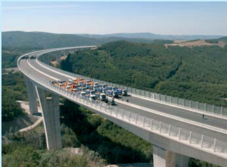
Med štiridnevним obremenilnim preizkusom so viadukt obremenili z 48 tovornjaki s skupno težo 1.200 ton.
