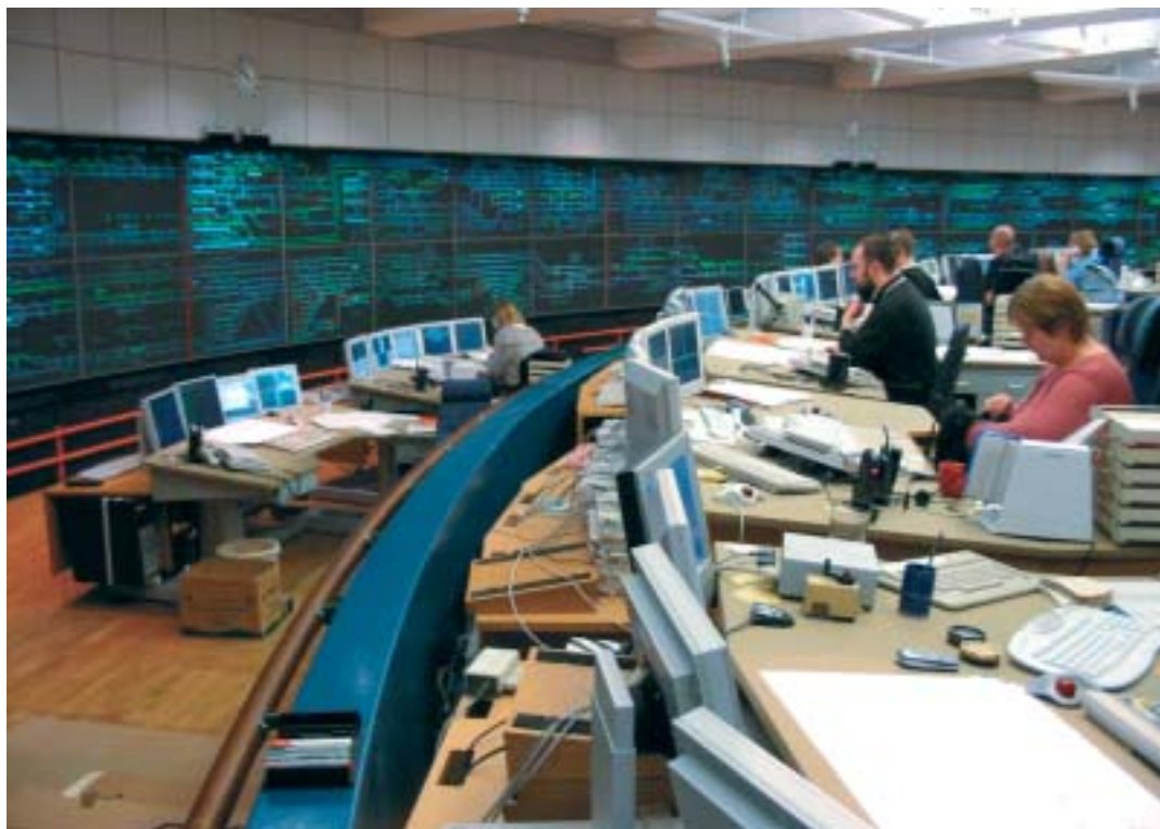
Takole na Švedskem z enega mesta poteka vodenje prometa na 4.000 kilometrih prog.
