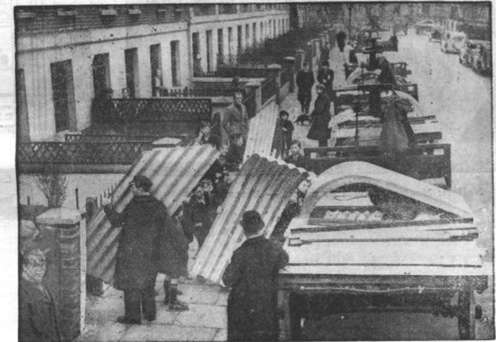
JEKLENA ZAKLONISČA. Angleška vlada je dala svojemu prebivalstvu na razpolago veliko množino jeklenih plošč, iz katerih se lahko hitro sestavi jekleno zaklonišče
