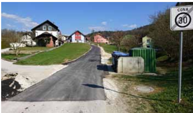
V teh dneh se zaključujejo tudi dela izgradnje podaljška vodovoda, meteorne kanalizacije in rekonstrukcija ceste v Rafolčah.
