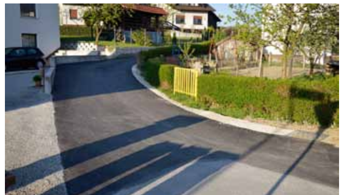
Izgradnje kanalizacijskega sistema, investicijskega vzdrževanja vodovoda ter asfaltiranje ceste Stranske ulice na Prevojah, je bilo v mesecu marcu že zaključeno.
