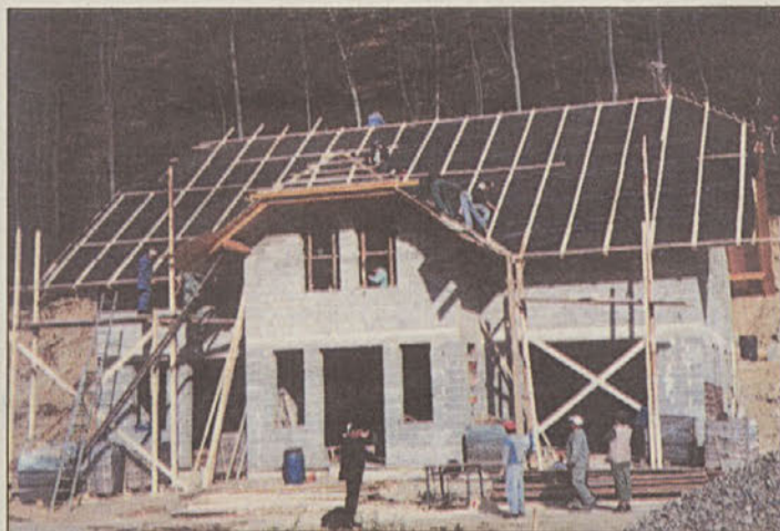
Večnamenski dom na Lukovcu v izgradnji
