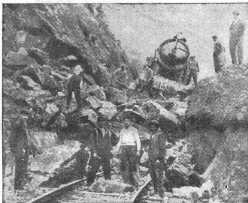
LOKOMOTIVA V SKALOVJU. V bližini Torsiača na Francoskem je zavozila lokomotiva potniškega vlaka v kup skalovja, ki se je bilo zrušilo na progo.
