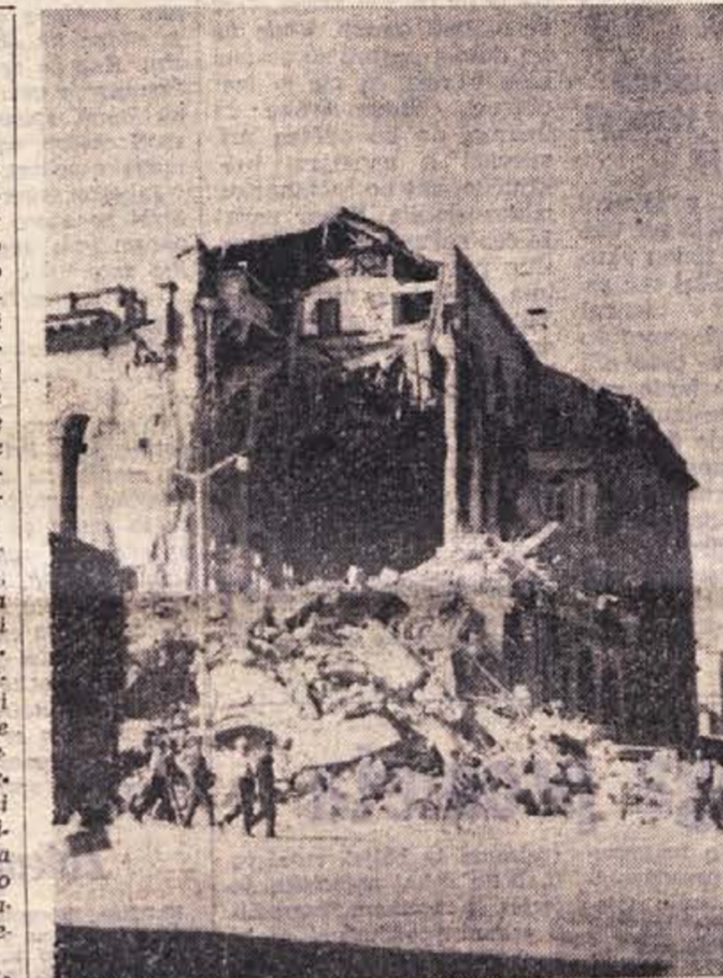
Tak je dom JLA v Skopju danes: kar še stoji, je polno nevarnih razpok. Dva lestena, težka po 1200 kg, pa še vedno visita na oboku velike dvorane...
