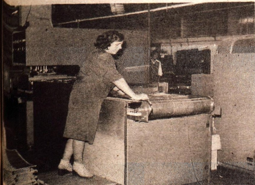
plastične mase varijo na polnoavtomatskem stroju za visokofrekvenčno varjenje. Prihodnjih pet let bodo največ vlagali v posodobitev proizvodnje, posebno pozornost bodo posvetili rednemu in izobraževanju ob delu, s čimer nameravajo dvigniti produktivnost dela. — Foto: F. Perdan
