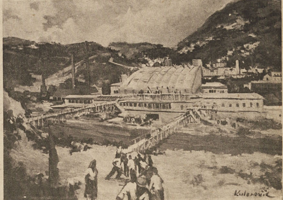
Gradnja nove železniške postaje v Sarajevu, Hakija Kulenović
