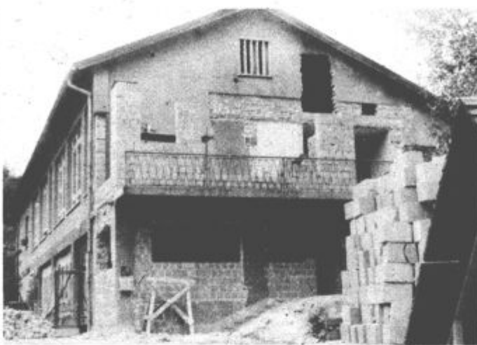
Obnovitvena dela potekajo hitro in brez zastojev, zato upajo, da jih bodo končali v predvidenem roku
