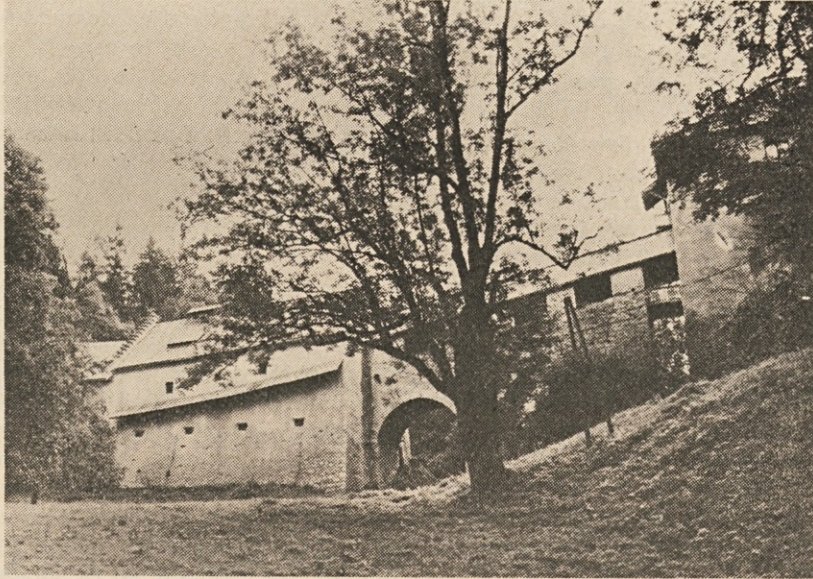
Občudovanja vreden pokriti dohod v Humperški grad. Prvi del je masivna podolgovata stavba z renesančnim portalom na čelni strani. Drugi del je pokrit most nad dvema lokoma, ki ju opirata mogočna stebra. Med njegovim gornjim koncem in gradom je bil prvotno vzdigni most, danes pa navaden lesen most. Za njim so bila nekoč močna okovana vrata v grad, na notranji strani gradu ob dvorišču pa druga. Pozidal ga je humperški gospod, grof Sigmund Helfried von Dietrichstein, v drugi polovici 17. stoletja.
