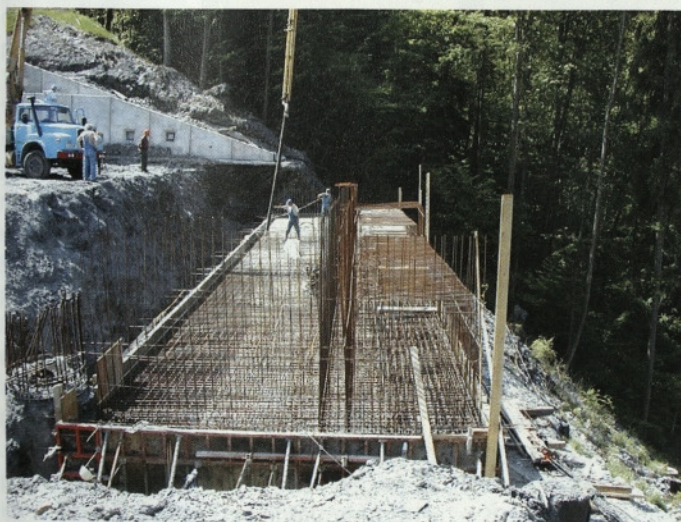
Slika 10 • Betoniranje pilotne blazine krajnega opornika v osi 1
