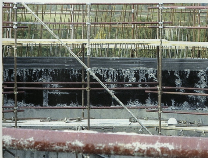
Slika 9 • Detajl vodoravnega delovnega stika
