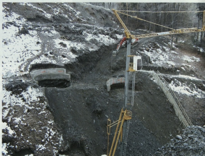
Slika 7 • Izkop vodnjakov v osi 3
