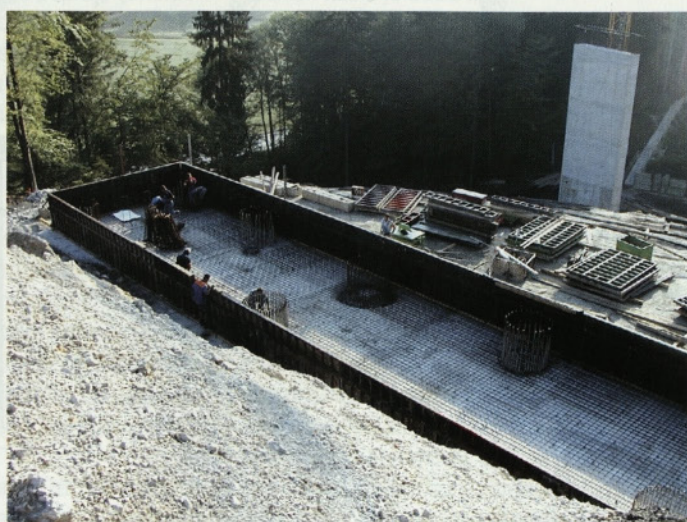
Slika 11 • Montaža opaža pilotne blazine krajnega opornika v osi 4
