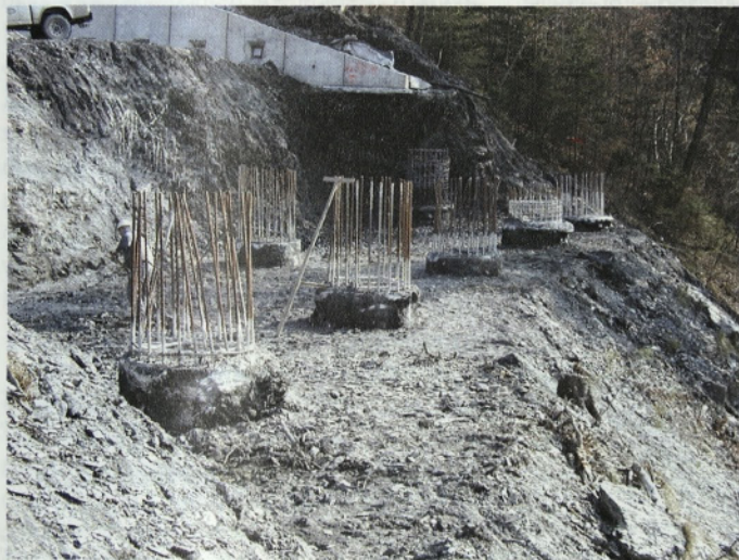
Slika 8 • Piloti na krajnem oporniku v osi 1
