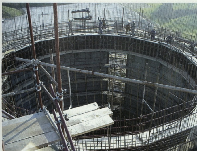
Slika 20 • Opaževanje cilindrične stene primarnega zgoščevalnika (objekt 17)
