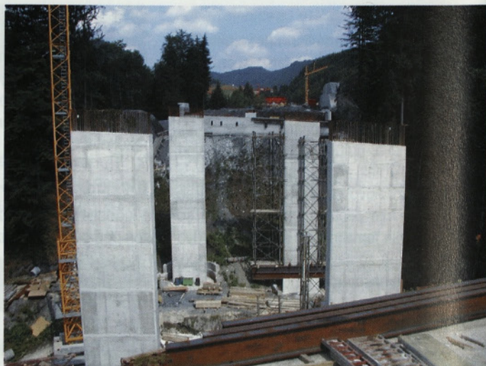
Slika 13 • Stebri desnega objekta
