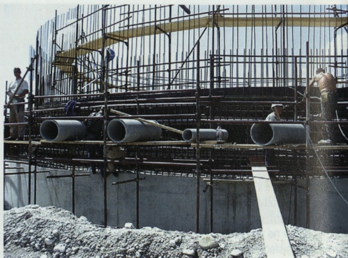
Slika 12 • Vgradnja stekleno cementnih cevi med opažni stranici cilindrične stene
