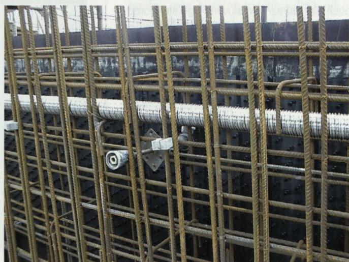
Slika 10 • Detajl neprepustne vezave opaža cilindrične stene
