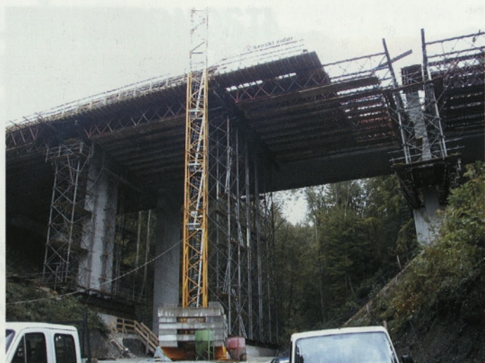
Slika 16 • Nosilni opažni oder prekladne konstrukcije desnega dela
