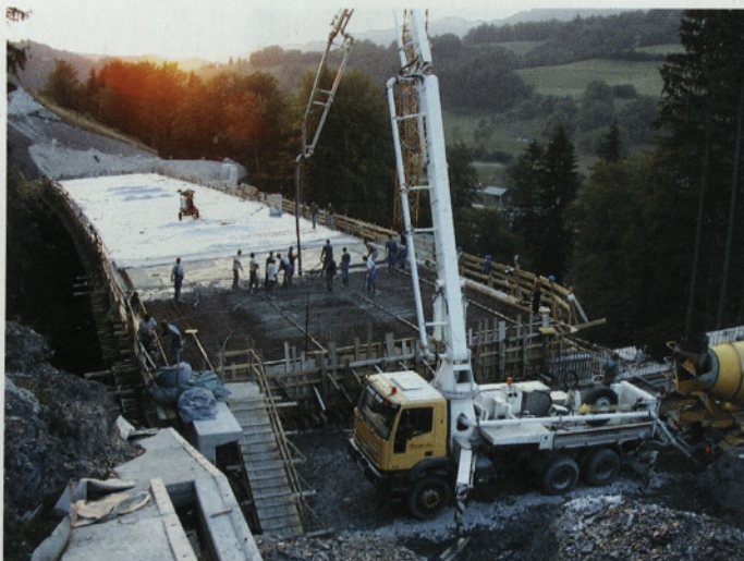
Slika 17 • Betoniranje prekladne konstrukcije levega objekta
