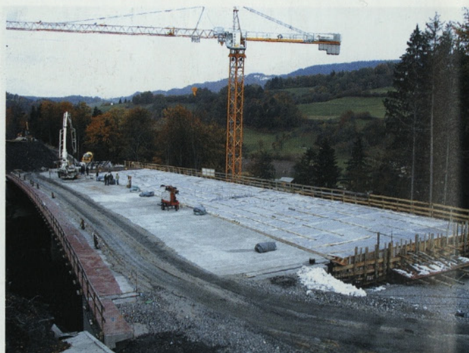
Slika 18 • Betoniranje prekladne konstrukcije desnega objekta
