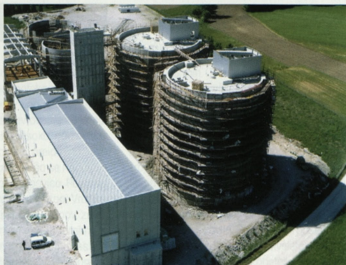
Slika 22 • Gradnja gnilišč (objekt 20) in primarnih zgoščevalnikov (objekt 17)
