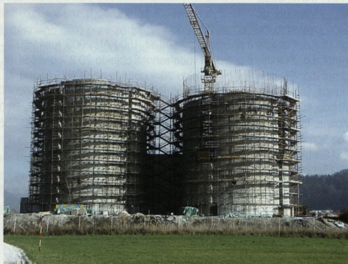
Slika 21 • Fasadni oder gnilišč (objekt 20)
