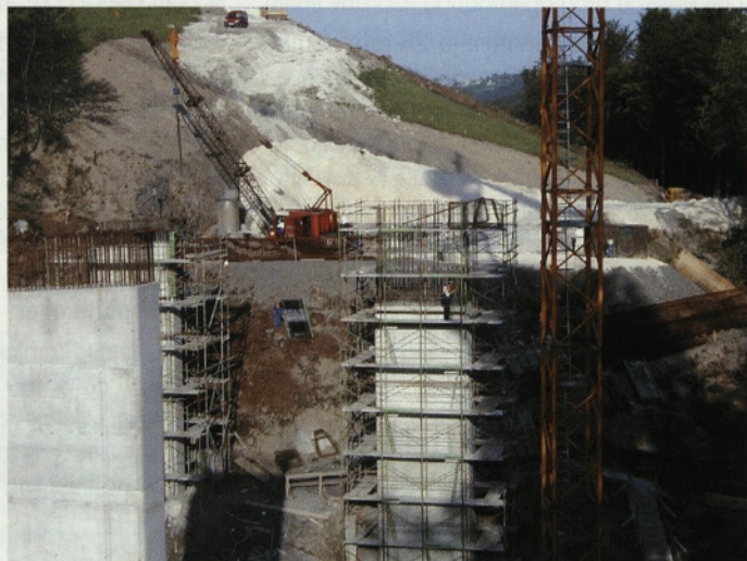
Slika 9 • Izdelava pilotov za krajni opornik v osi 4
