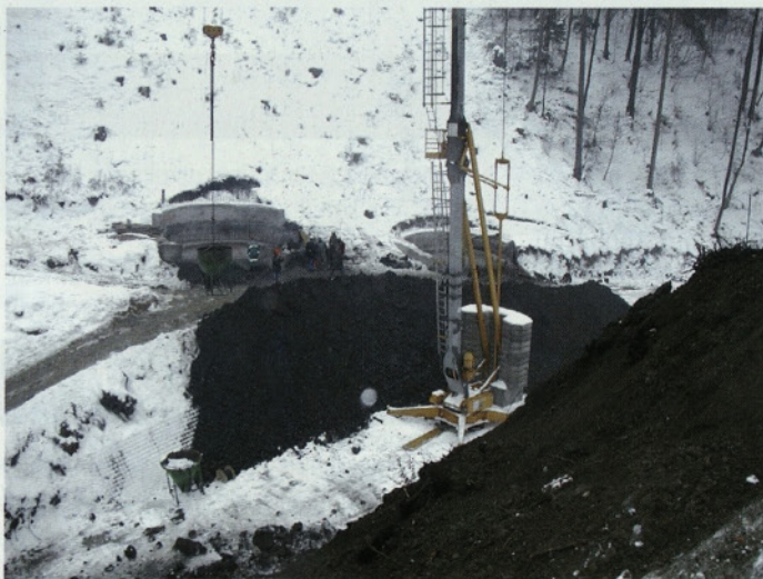
Slika 6 • Izkop vodnjakov v osi 2
