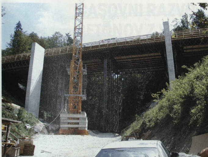
Slika 15 • Nosilni opažni oder prekladne konstrukcije levega dela
