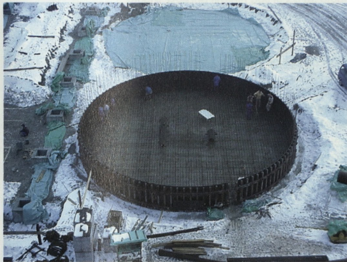
Slika 19 • Opaževanje talne plošče primarnega zgoščevalnika (objekt 17)
