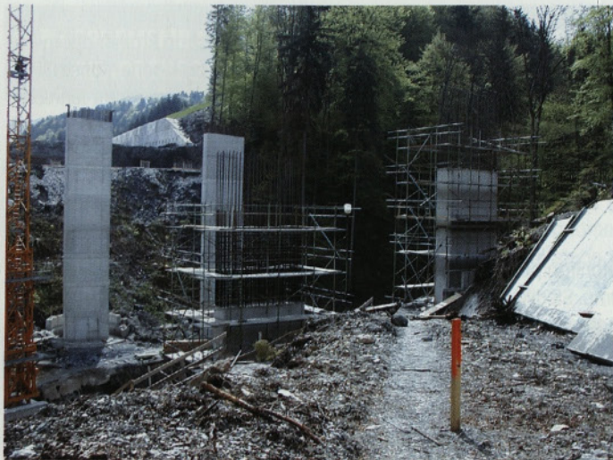
Slika 12 • Gradnja stebrov levega objekta
