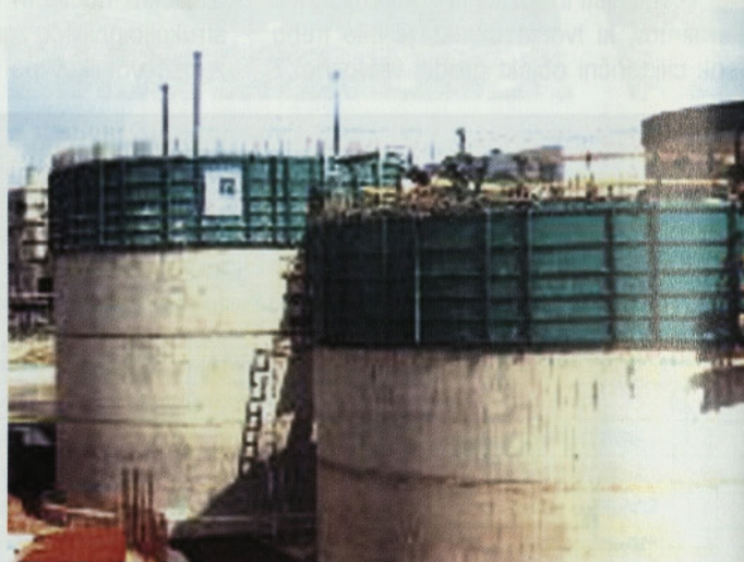
Slika 17 • Detajl opažnega sistema sklenjenega kroga s hidravliko
