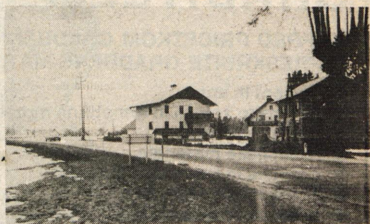
Na severnem delu Britofa proti Miljam je še čas, saj se bo na tem področju gradnja šele začela.
