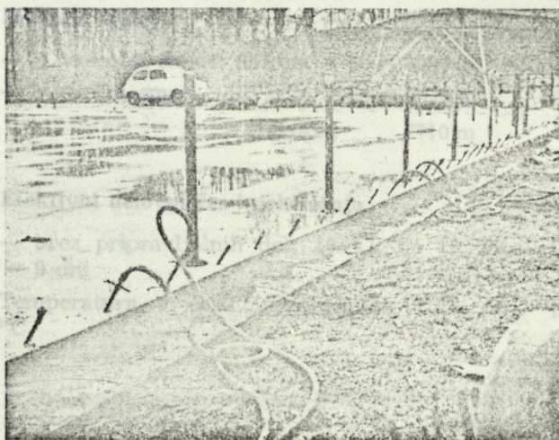
Sl. 6. Injektiranje cevi z napetimi kablji v prečni smeri plošče.
