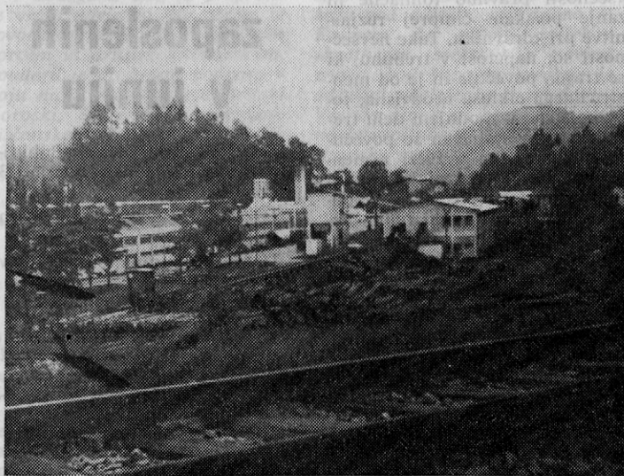
Pogled na sedanjo žago na Rečici
