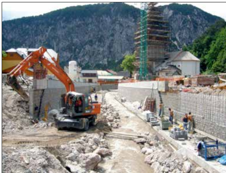
Slika 1: Ureditve hudournika v Ukvah pri Trbižu (Italija). Poplavna varnost se zagotavlja le s povečanjem pretočnega prereza in dvigom zidov.
