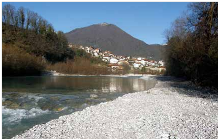
Slika 7: Zadrževalnik plavin na Tolminki pod Tolminom.
