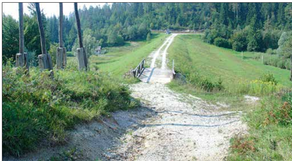
Slika 13: Pregrada zadrževalnika visokih vod na potoku Reka nad Logatcem.
