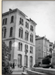
Poškodovana stavba Narodne banke v Splitu
