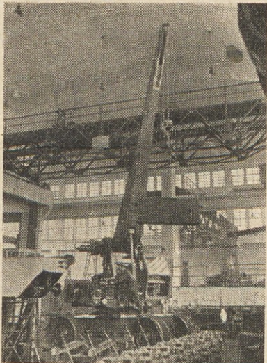
6-tonski avto-žerjav med montažo
