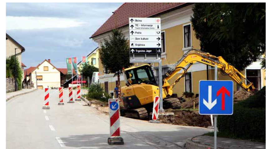
Gradnja pločnika proti Domu kulture v Rakovljah in prehoda za pešce
