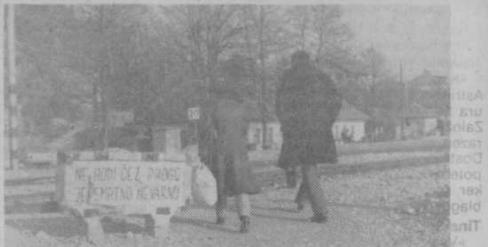
Opozorilni napis je premalo za varnost pešcev.
