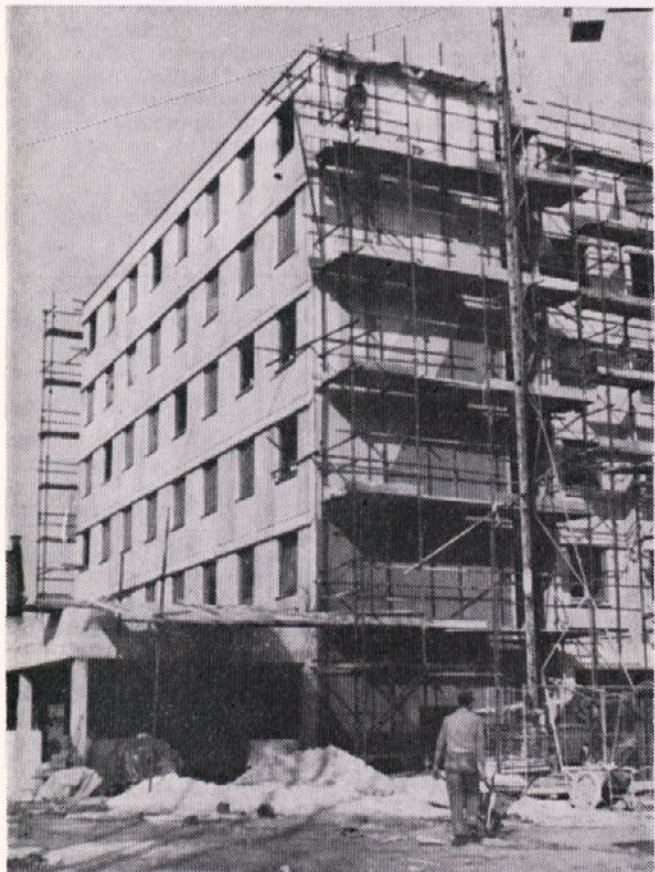
Na Dijaškem domu končujejo s slikanjem fasade
