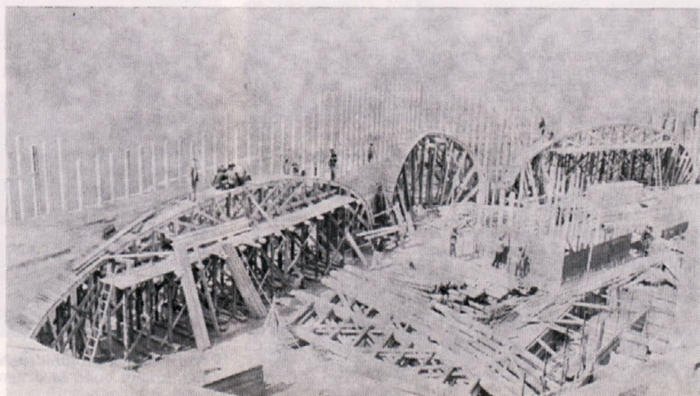
V letu 1966/67 smo gradili v Kraljevcu zanimiv in zahtevni hotelski objekt »Uvala Scott«. Na gradbišču se je delalo podnevi in ponoči. Naši tesarji so pod nadzorom Rafka Funkla montirali opaže za primarne (na levi) in za sekundarne loke (na desni), ki so bili prej natančno izdelani v delavnici na Gomilskem.
