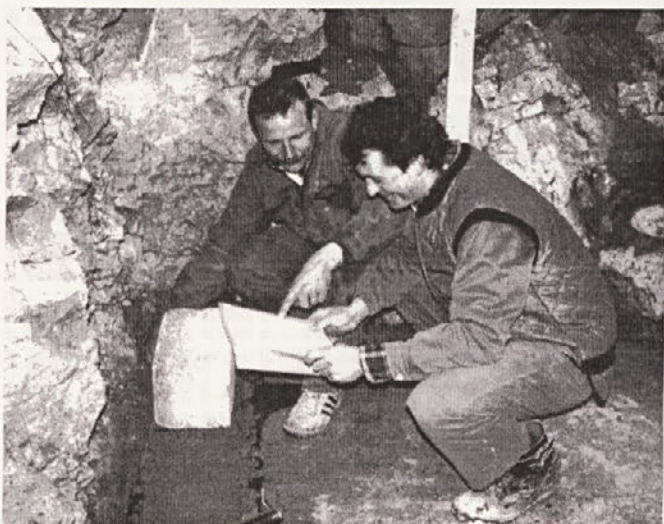
To naj bi bil svečan trenutek polaganja prvega zidaka za prizidek k telefonski centrali
