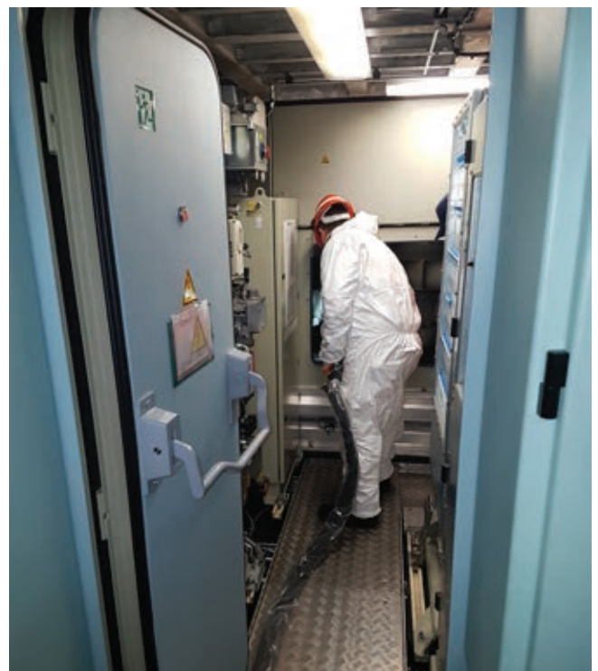
» Čiščenje oljnega hladilnika nameščenega na lokomotivi | Vir: mycon
