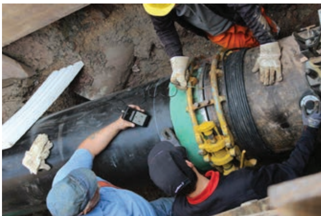
» Merjenje jakosti polja pred varjenjem. Novi cevni odsek ni bil razmagnetjen.
