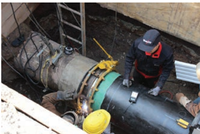
» Varjenje prvega odseka cevi
