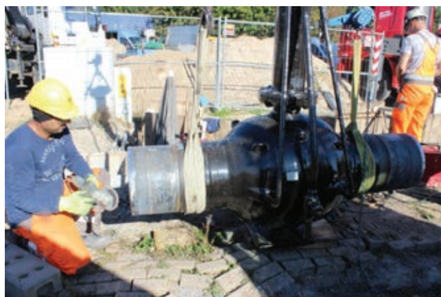
» Nova krogelna cev pred vgradnjo
