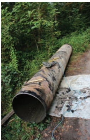
» Zunanost odseka cevi
