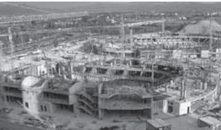
Slika 19: Fotografija gradbišča. Vir Skyscrapercity.
