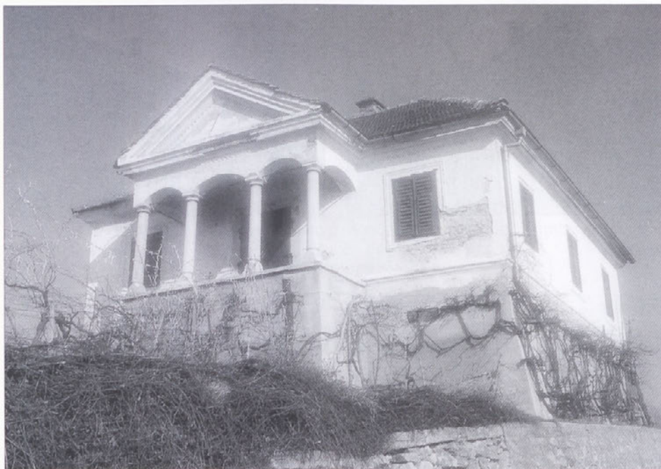
Slika 20: Vinogradniški dvorec na Humu čaka na temeljito obnovo
