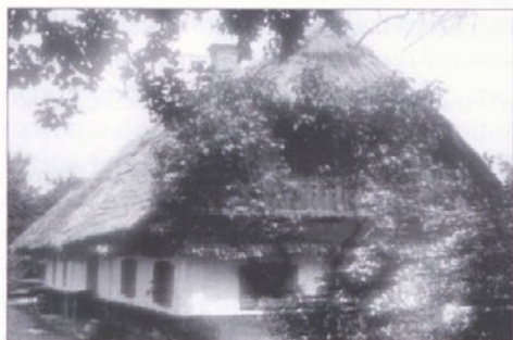
Slika 3: Runeč 24: Cimprana s slamo krita hiša, zgrajena leta 1797, porušena leta 1997
