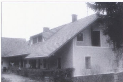
Slika 24: Spodnji Ključarovci 1: Z neustrezno obnovo uničen etnološki spomenik
