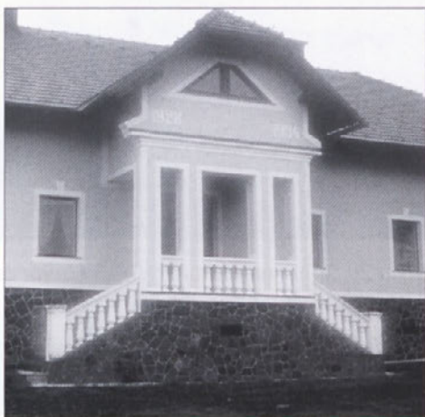
Slika 26: Spodnji Ključarovci 1: Neustrezno obnovljen vhodni del
