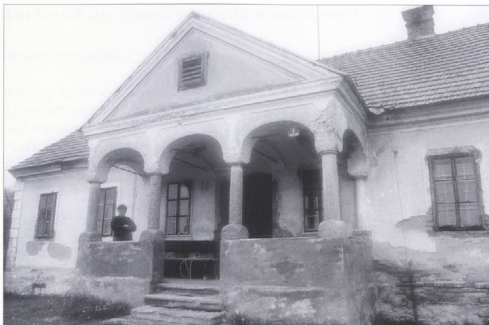
Slika 29: Vinski vrh 1: Hiša z značilno vhodno stebriščno verando pred obnovo
