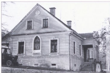
Slika 23: Spodnji Ključarovci 1: Hiša pred obnovo
