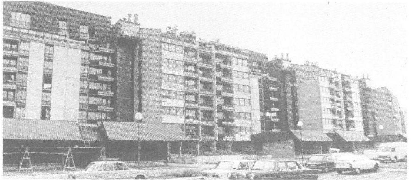
Prvi niz blokov je zgrajen
