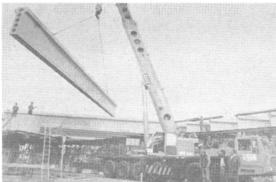
In tu je nadvoz na zahodni obvoznici
