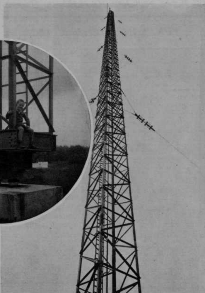
Del antenskega stolpa z jeklenim predalčjem. V krogu zgoraj: Porcelanasto podnožje stolpa.
