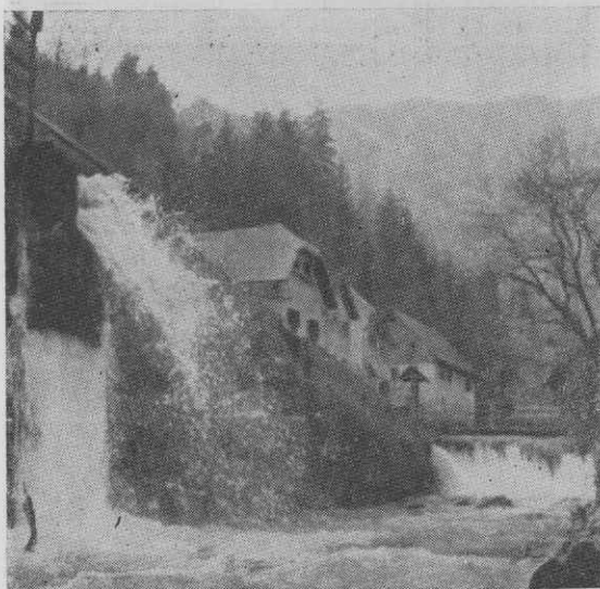
Jez, rake, skrinja in voha Srednjega mlin v Kropi iz kamnov Zgornjega plavža
