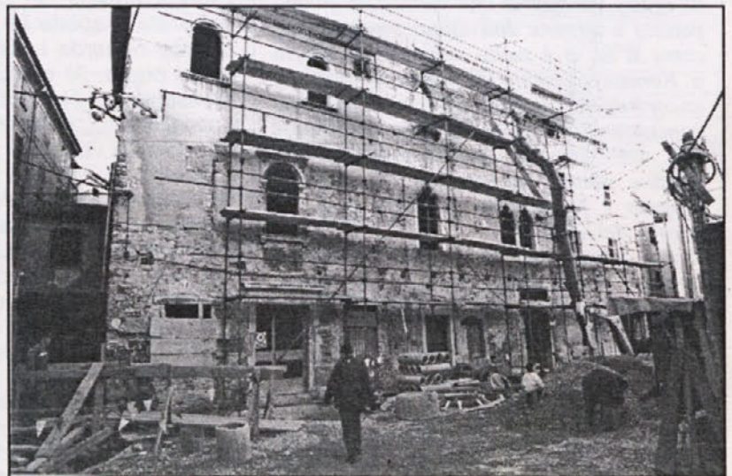
Il cantiere di "Palazzo Manzioli"
