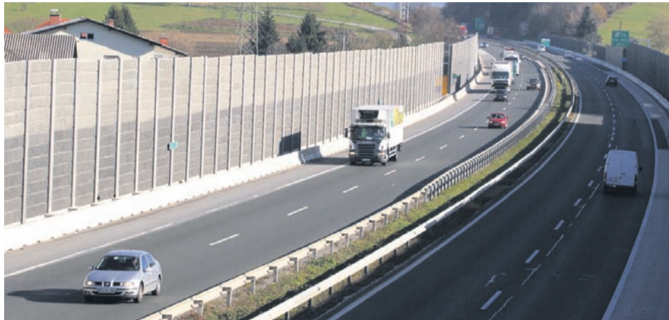
Protihrupne ograje Dars postavlja skladno z uredbo za zaščito okoliških prebivalcev. Čeprav sivi betonski zidovi ponekod močno kazijo pokrajino in omejujejo pogled, so se prebivalci v bližini ograje že skoraj navadili živeti z njo in s prometom. Seveda bi bilo še bolje, če bi v polni meri služile namenu, pravijo.
