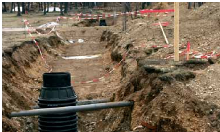
Gradbišče komunalne kanalizacije
