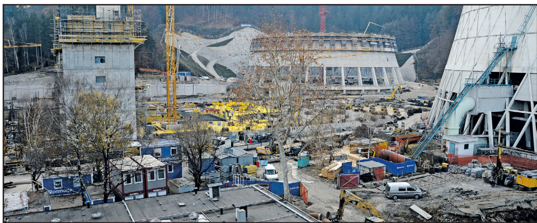
Nadzorni svet HSE ocenjuje, da je izgradnja šestega bloka strateškega pomena. Gradnja dobro napreduje. Novi objekti so vsak dan višji za kakšen meter.
