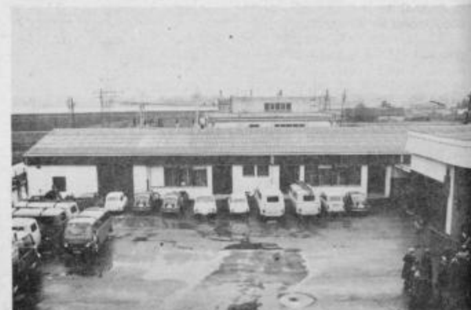
RTP, skladiščni in garažni prostori
