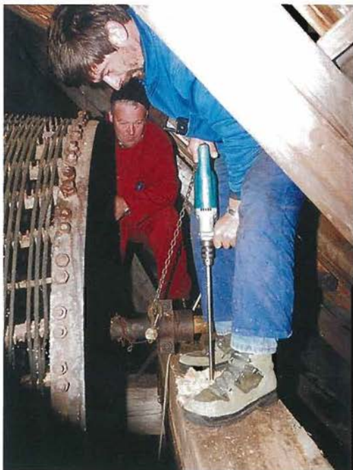
Slika 5: Tesar Darko Odar in muzealec Ciril Brancelj pritrjujeta nosilec navojnega bobna na nov macesnov tram (foto: Vilman, 1999)
